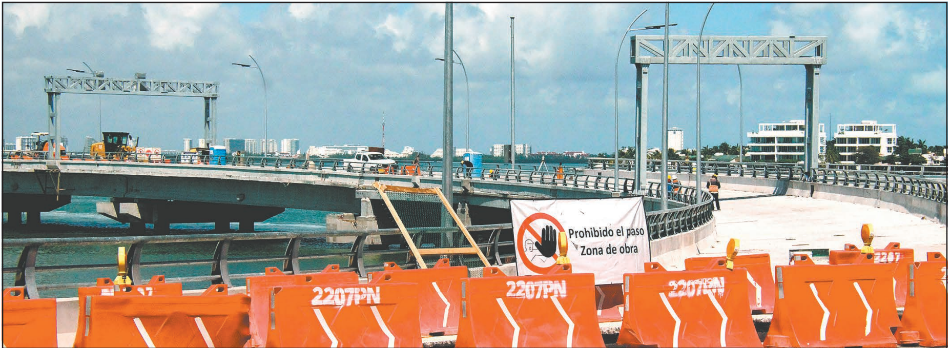
La obra es de las más esperadas por residentes y trabajadores para desahogar el tráfico en la zona hotelera y contar con una vía alterna en caso de emergencia. (Liza Vera)
