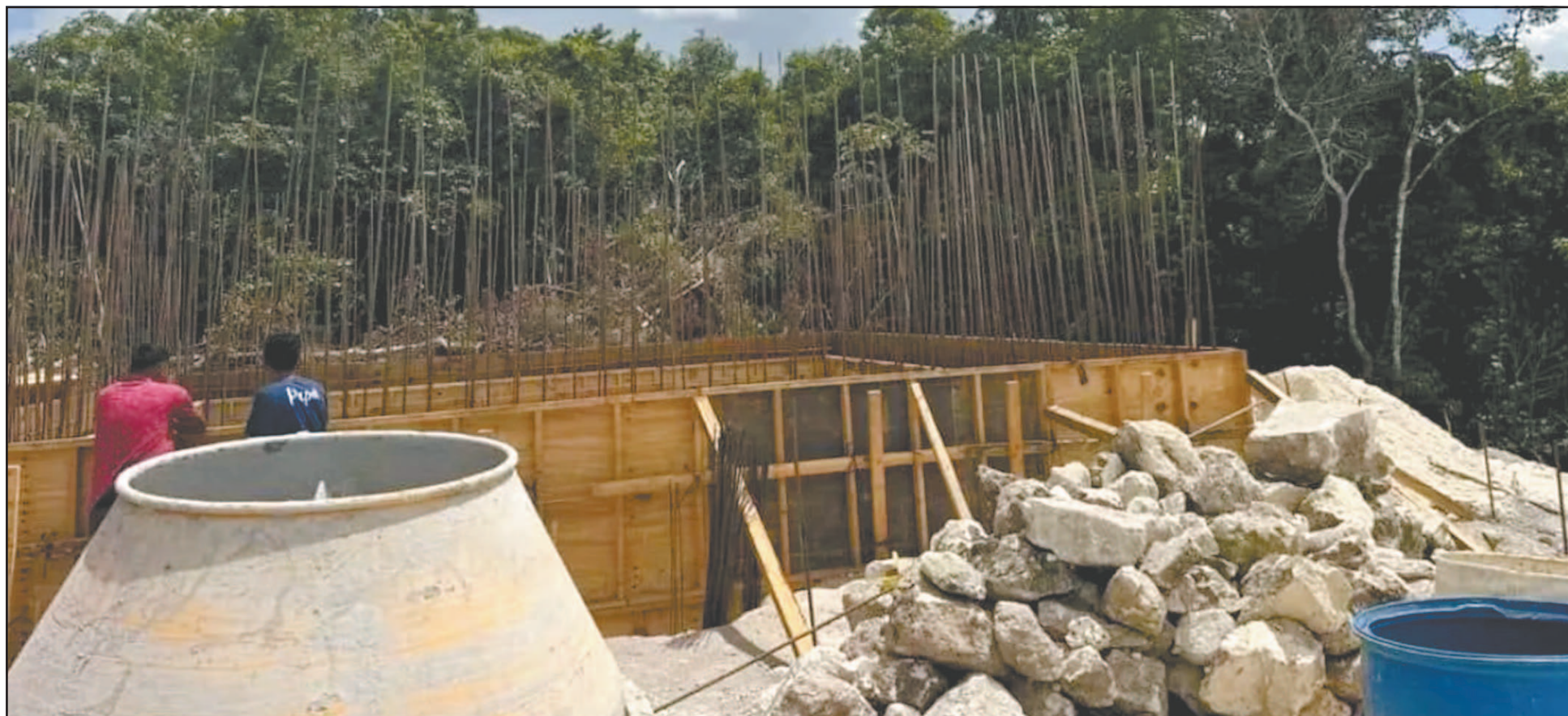
Entre los trabajos pendientes se encuentra un acueducto de Felipe Ángeles a Blasillo y un tanque de almacenamiento con capacidad de 250 mil litros. (Efrén Martín)
