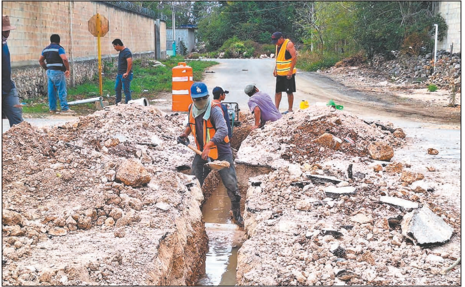
Los habitantes del municipio se han quejado de la falla en el bombeo y suministro, al parecer, por cortes en la energía eléctrica. (J. Xiu)
