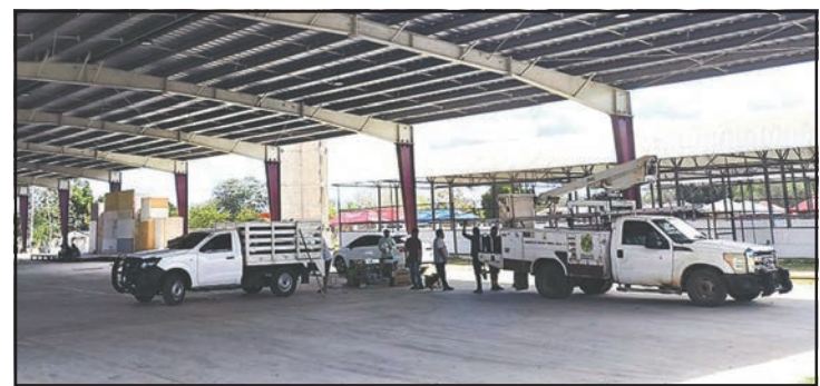
Comenzaron los trabajos de limpieza en el recinto ferial. (Lusio Kauil)
