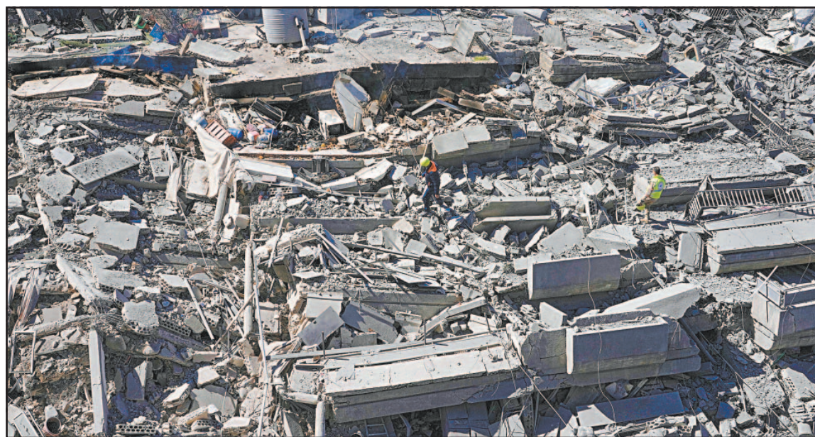
Rescatistas inspeccionan un edificio destruido por un ataque israelí, en la ciudad de Nabatiyeh. (AP)
