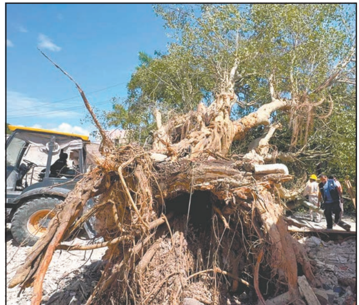
Inspectores locales frenaron trabajos de construcción. (G. Escalante)
