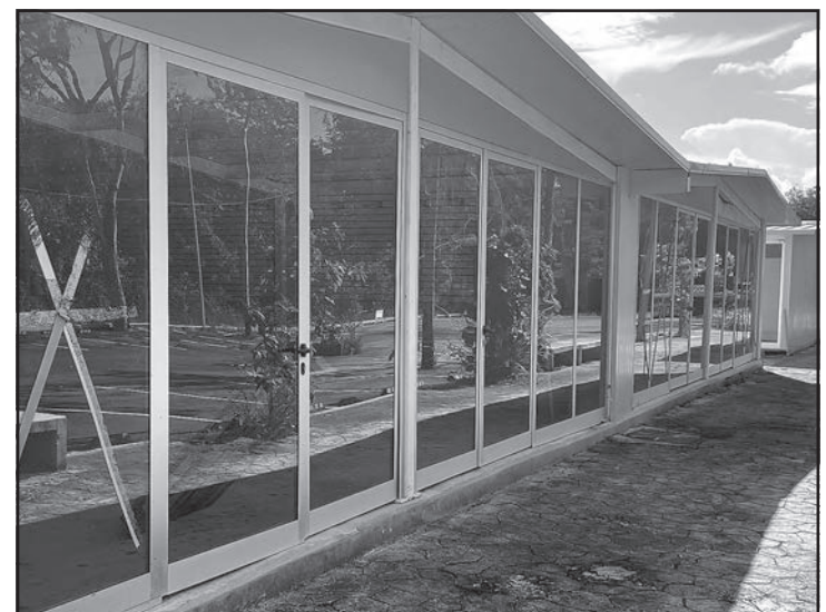
En la capital edificaron inmueble cerca del Banco de Sangre. (E. Martín)
