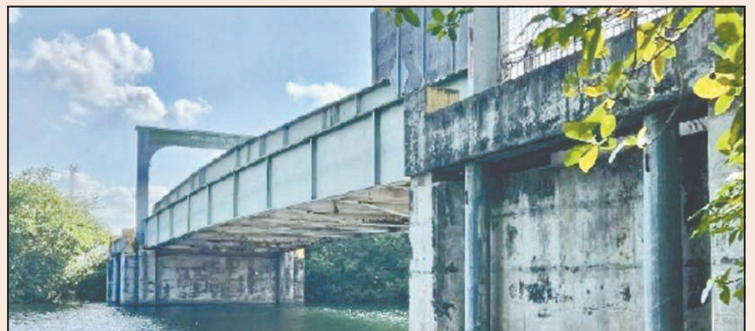
El proyecto de rehabilitación contempló guarniciones, muro de acceso y señalética. (POR ESTO!)
