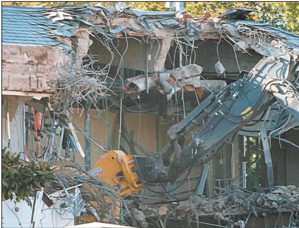
Para finales de octubre del año pasado, ya habían demolido parte del Ala Este de la mansión. (Agencias)
