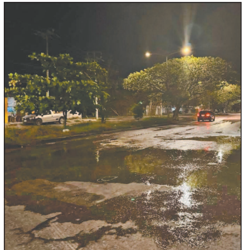
La calle Vigésima está convertida en un foco de infección. (A. Pech)
