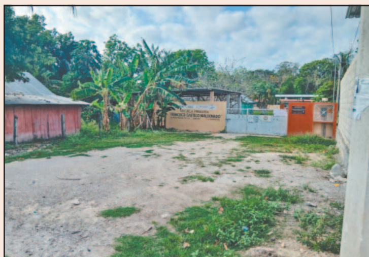
La entrada a la escuela está en pésimas condiciones (J. Guevara)
