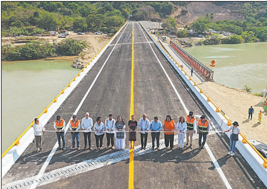
La Federación ha concluido 360 km de obra carretera, 4 mil 500 km de repavimentación y 78 puentes. (Agencias)
