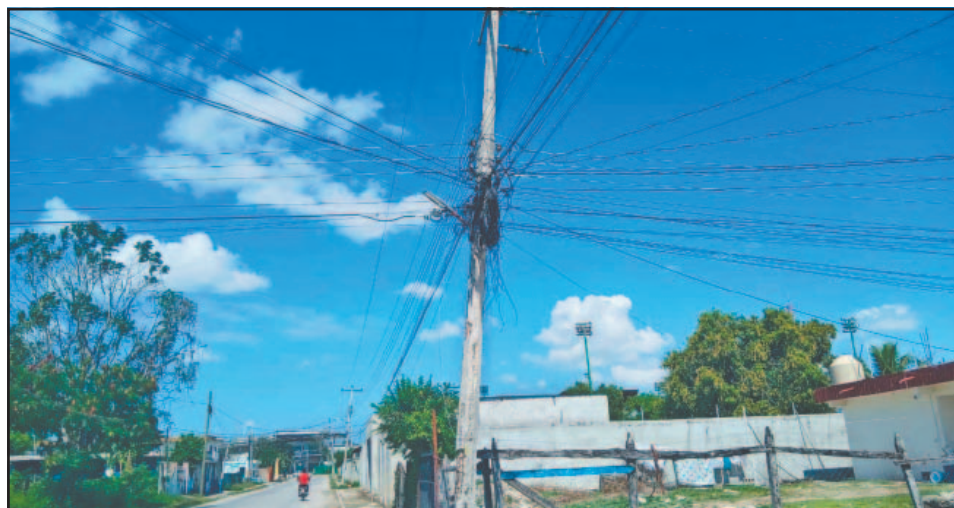
Hay mucha cablería, pero nada de lámparas que alumbren en la noche. (J. Guevara)
