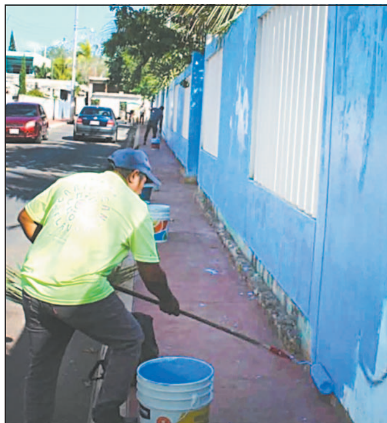
Se está llevando a cabo el mantenimiento de la pintura exterior.
