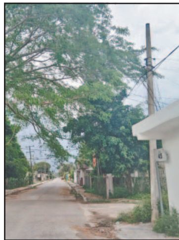
Solo Protección Civil o la CFE pueden prevenir un accidente.
