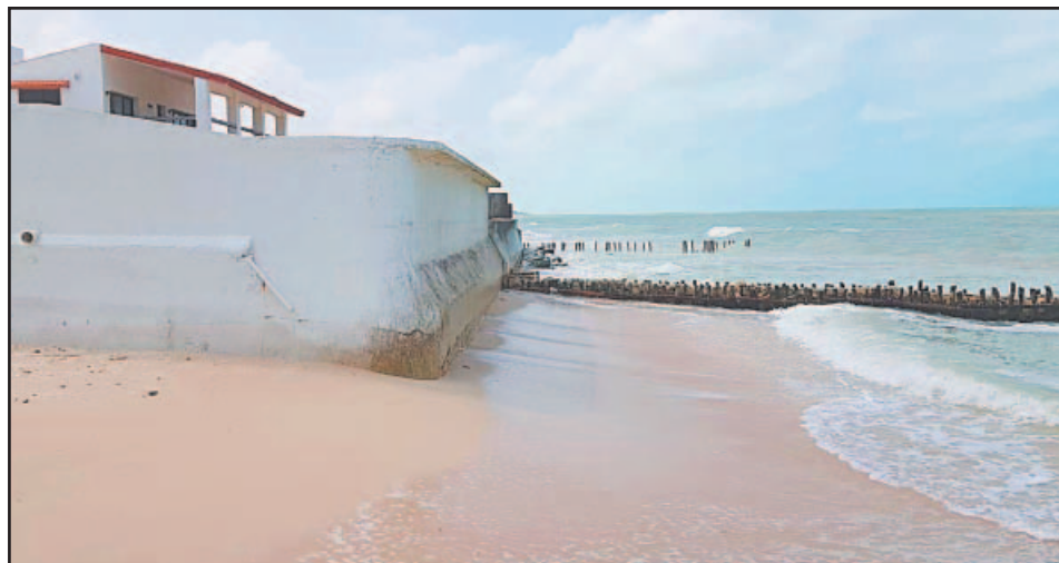
La instalación de espolones en vez de solucionar el problema lo agudiza. (POR ESTO!)
