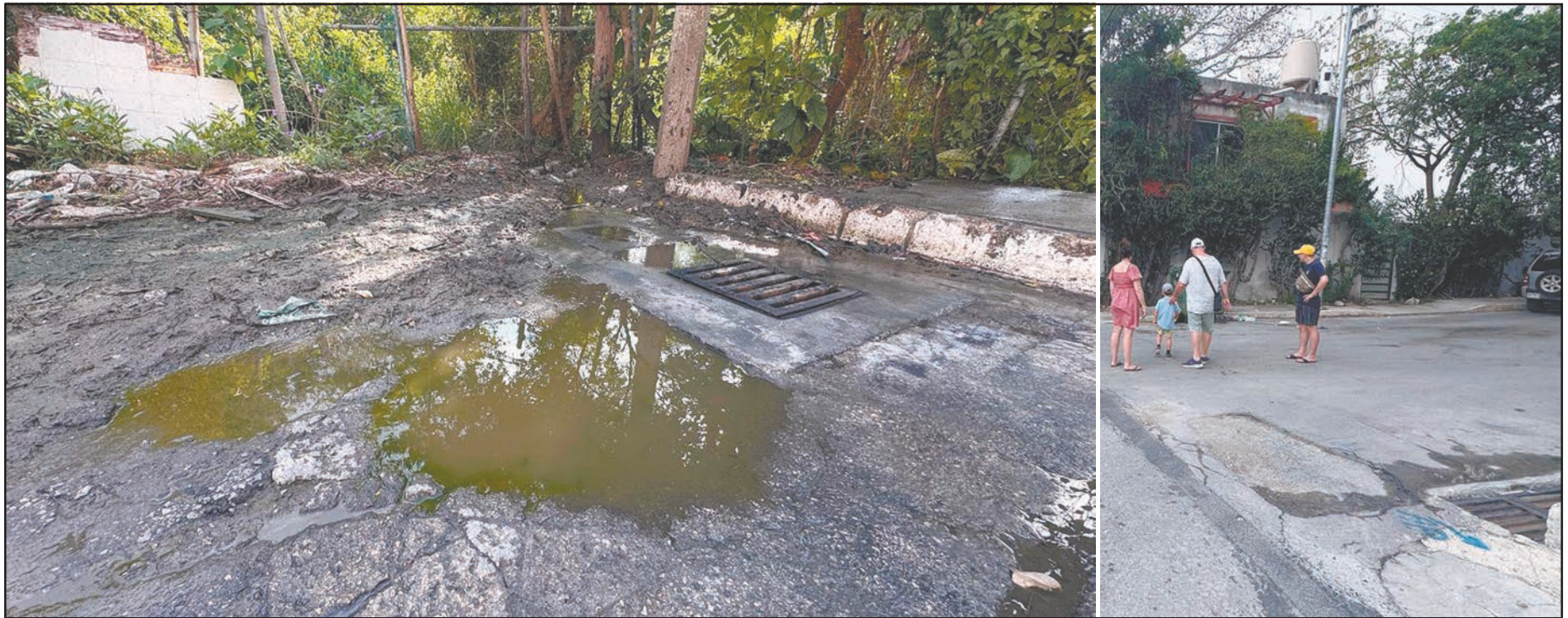
Habitantes señalaron que la zona afectada va de la calle 48 a la 54 norte, donde predominan los desechos por una falla en la infraestructura. (Fotos Gustavo Escalante)
