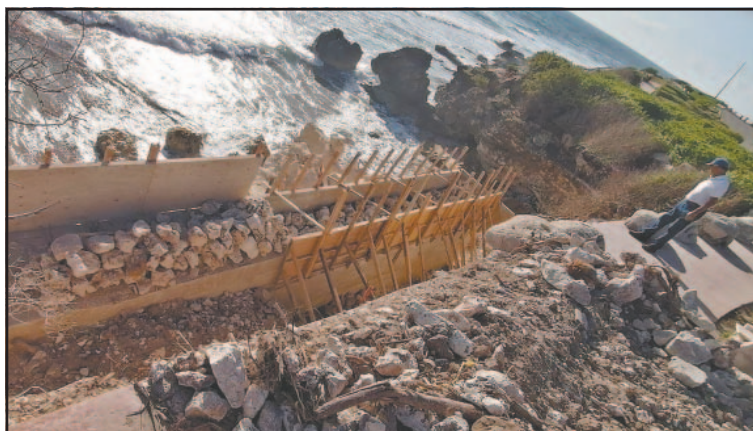
La Comuna comenzó a edificar un muro de 40 metros de largo. (O. López)
