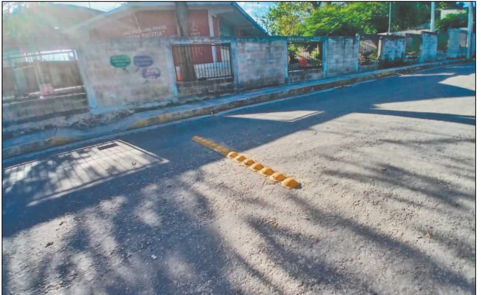
Media calle no cuenta con los reductores que los automovilistas esquivan sin importar que el plantel esté a un costado. (Joaquín Guevara)
