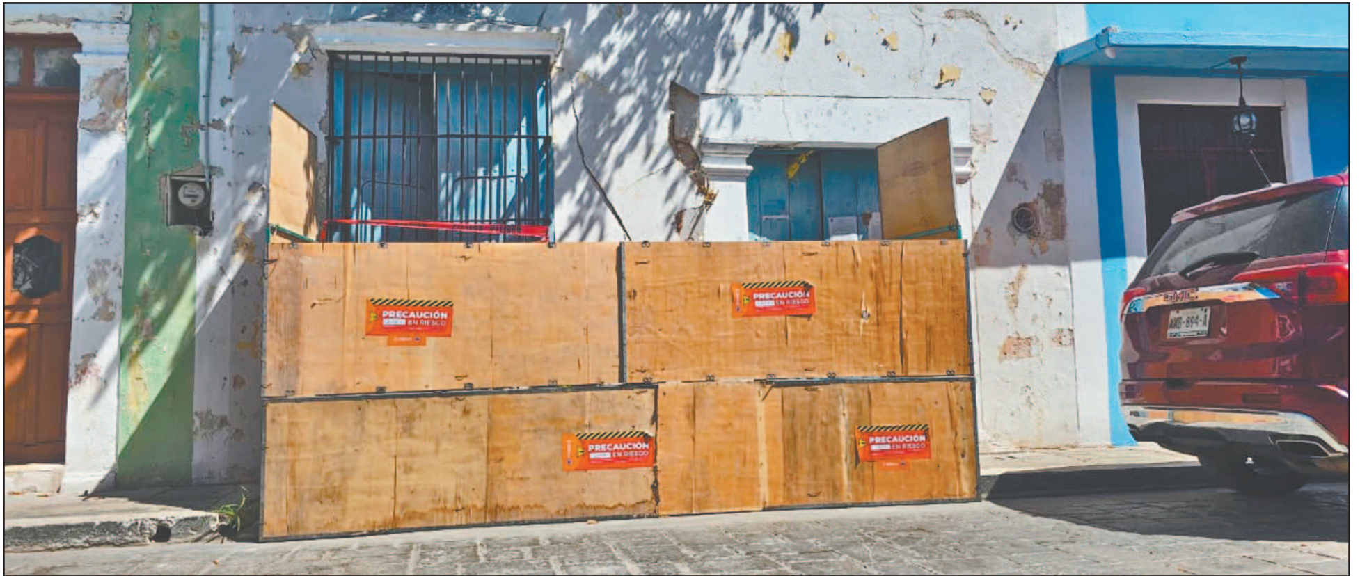
Los vecinos de la zona señalan que esta casa tiene años en el abandono, lo que ha permitido que la vegetación la cubra y que se extienda a otros predios. (Alejandro Pech)
