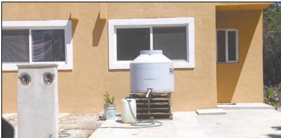
Personas apartan el fluido en cubetas o cisternas, ante la intermitencia del suministro.
