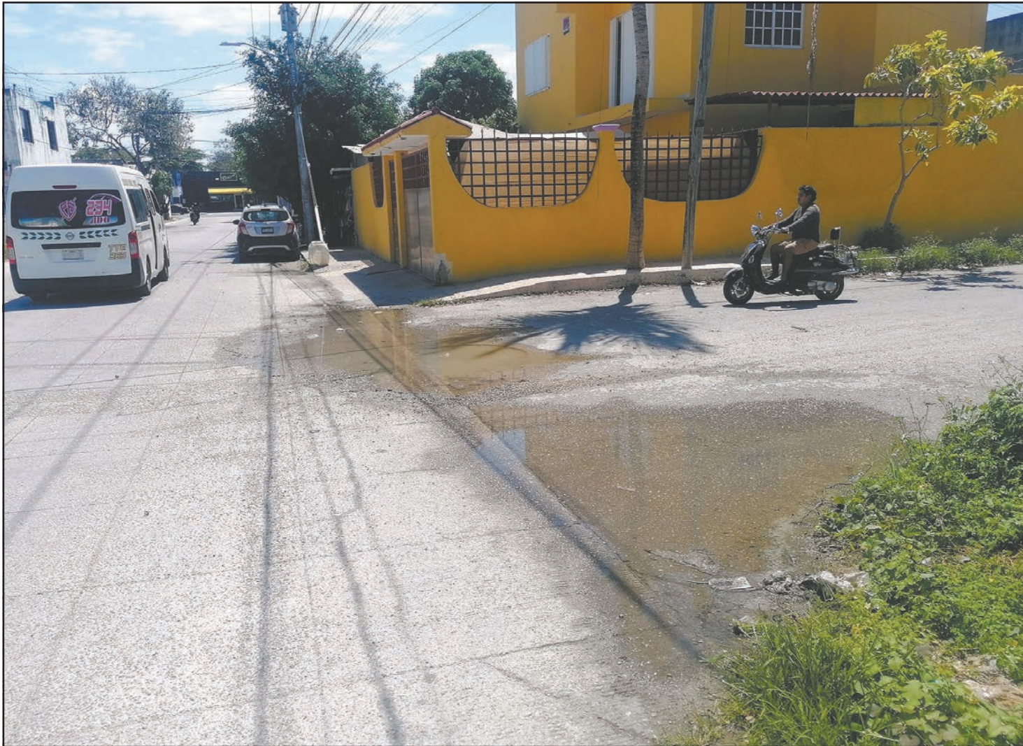
Residentes de varias zonas de Benito Juárez reportaron que las fugas generan baches, aunado a que se pierden miles de litros del líquido vital.
