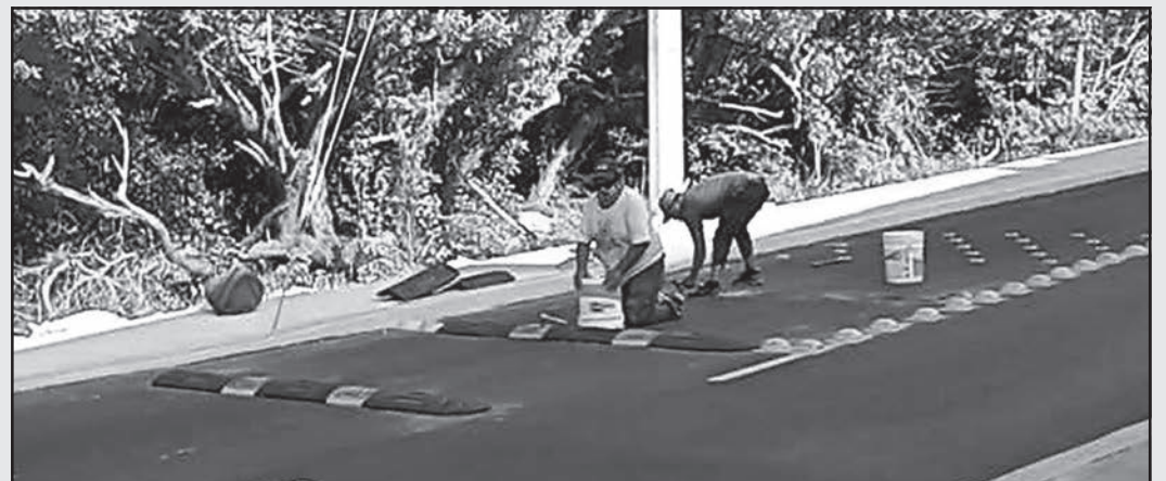
Conductores pidieron colocar reductores podotáctiles, a fin de disminuir accidentes. (Ovidio López)
