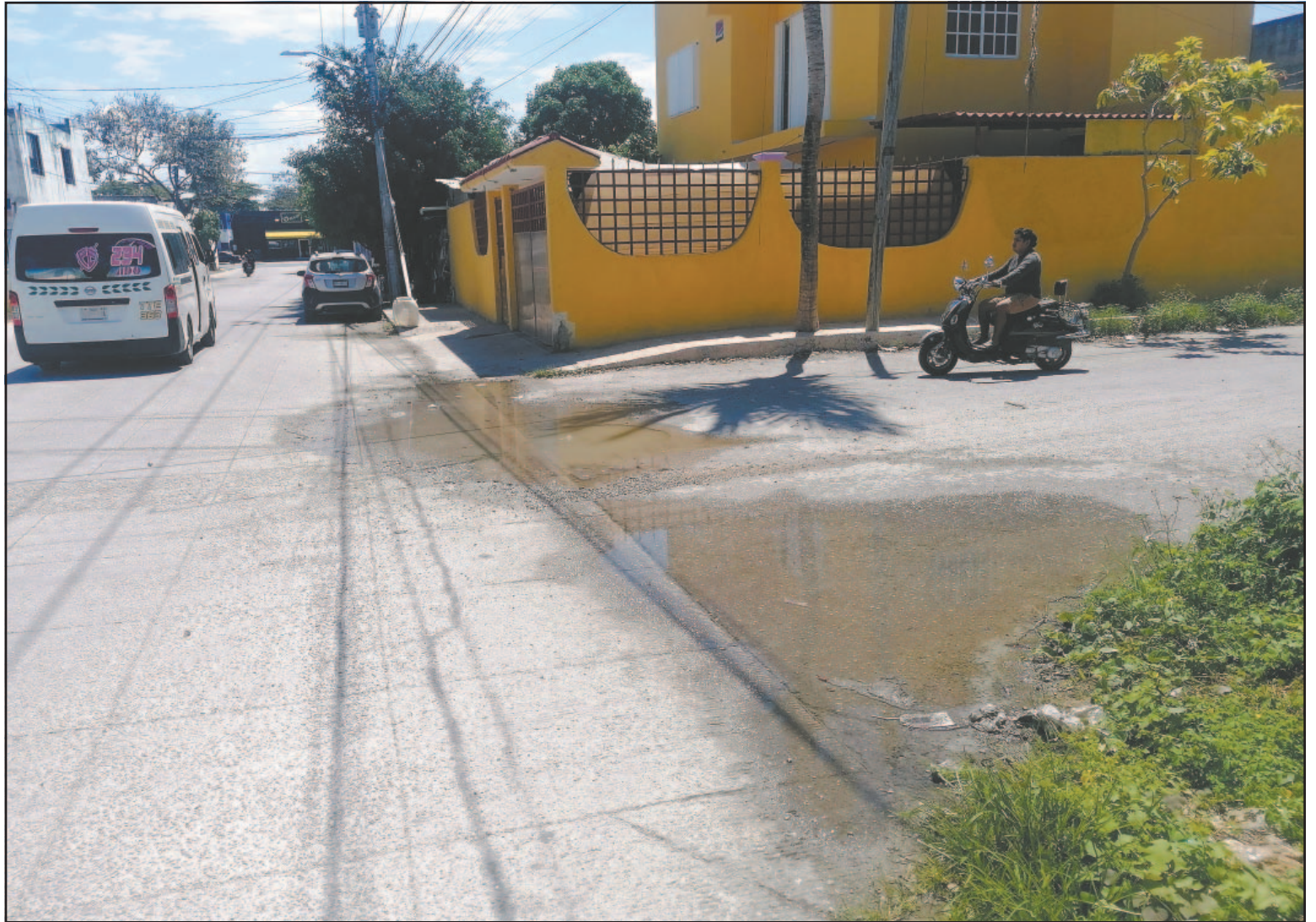
Residentes de varias zonas de Benito Juárez reportaron que las fugas generan baches, aunado a que se pierden miles de litros del líquido vital.
