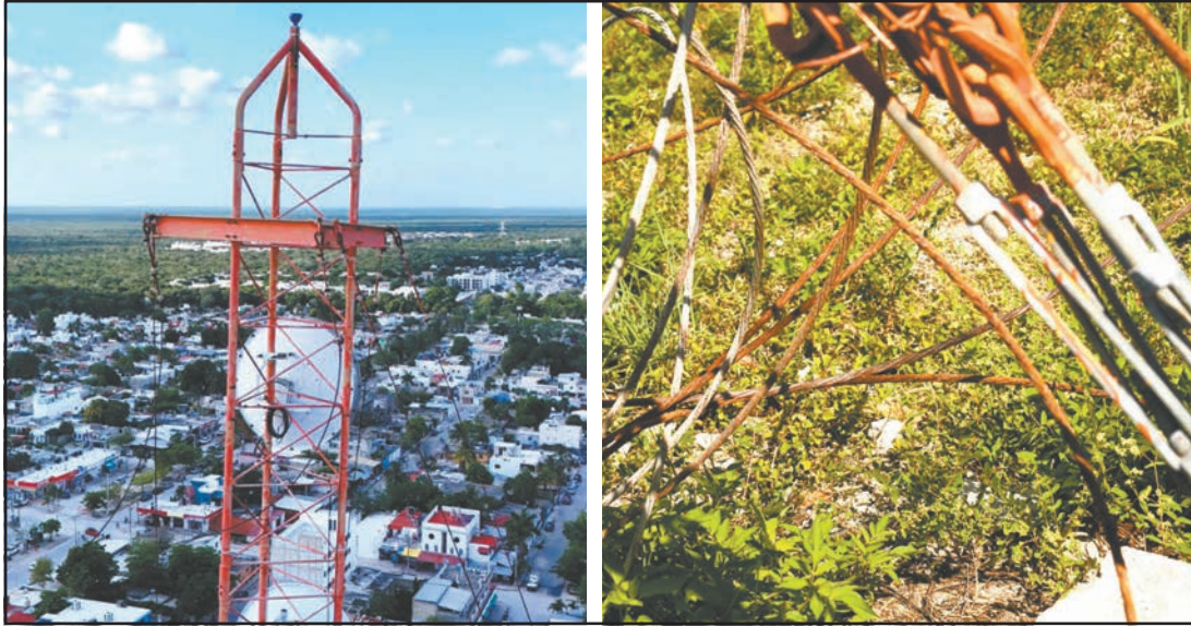
Ciudadanos reportaron que varios tensores de la instalación, de 10 metros, se reventaron. (Fotos POR ESTO!)
