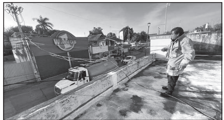
Atendieron cables a baja altura en el centro de la ciudad. (J. Xiu Chan)
