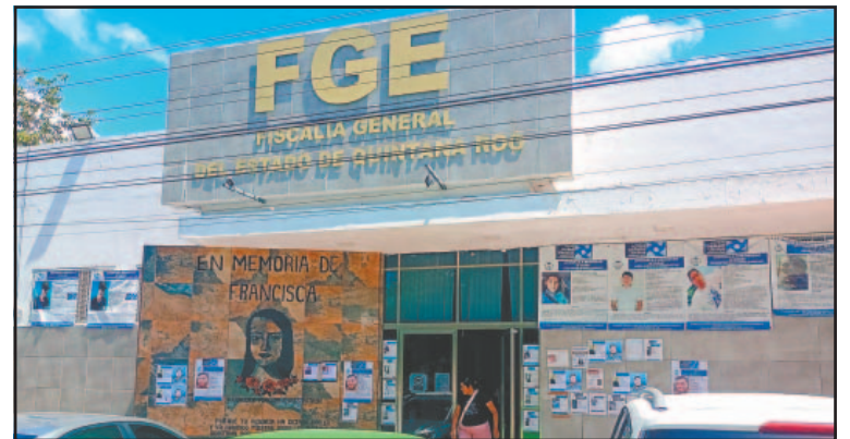
La fachada del inmueble está saturada de fichas de personas desaparecidas.
