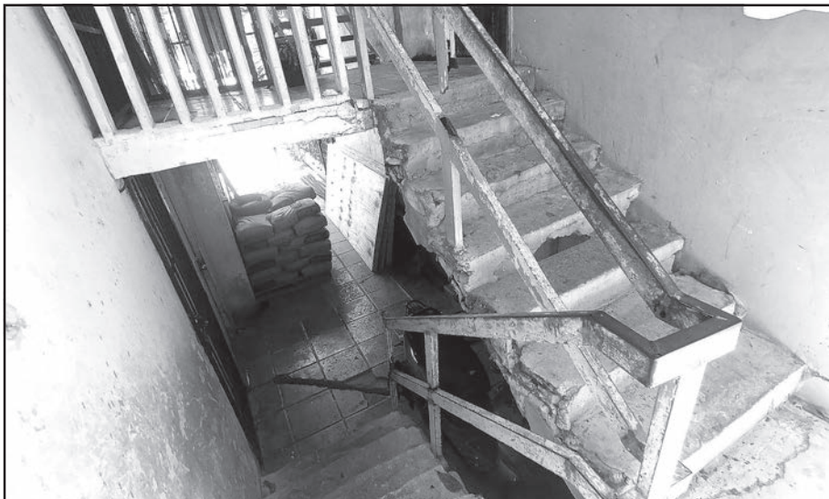
Vecinos ya compraron material de construcción que incluye cemento y unas tablas.
