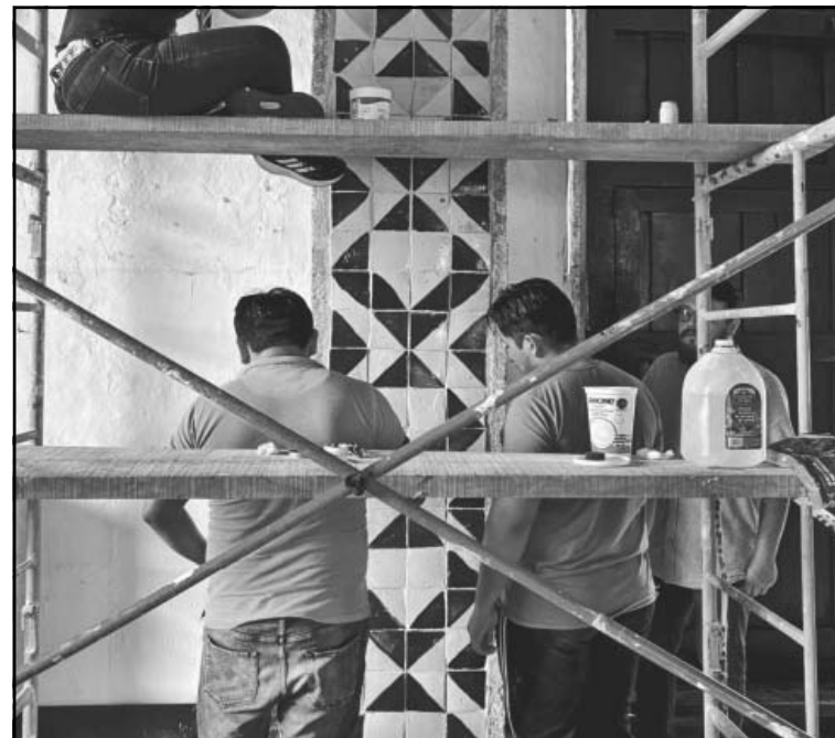
Algunos trabajos continuarán después de la Semana Santa. (A. Pech)
