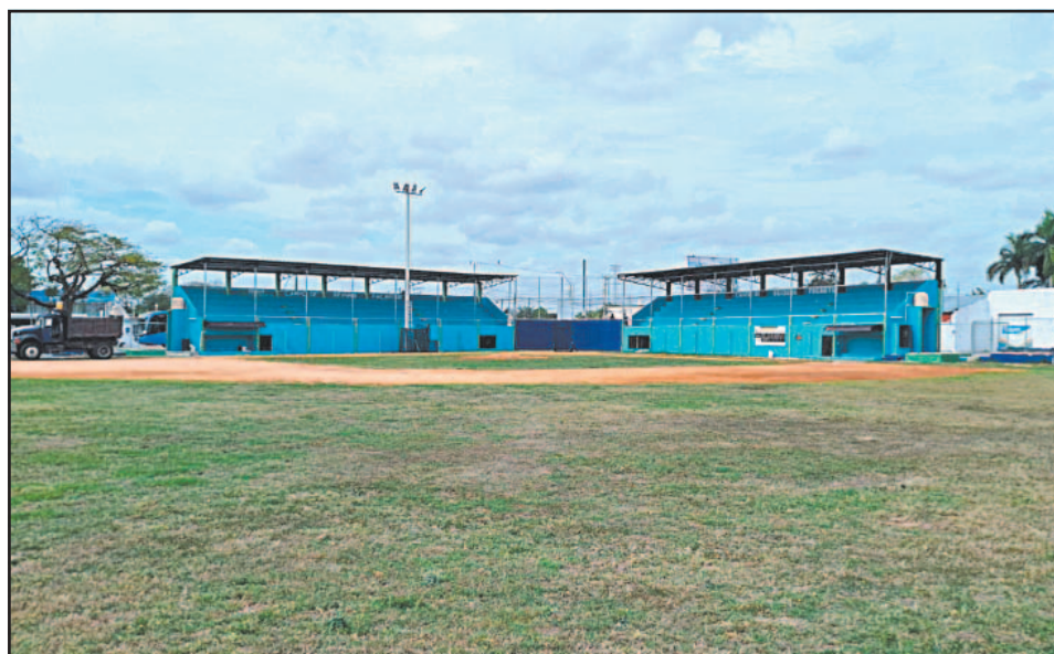
Las obras en el recinto de Pacabtún (inaugurado en 1997) acabarán la próxima semana.
