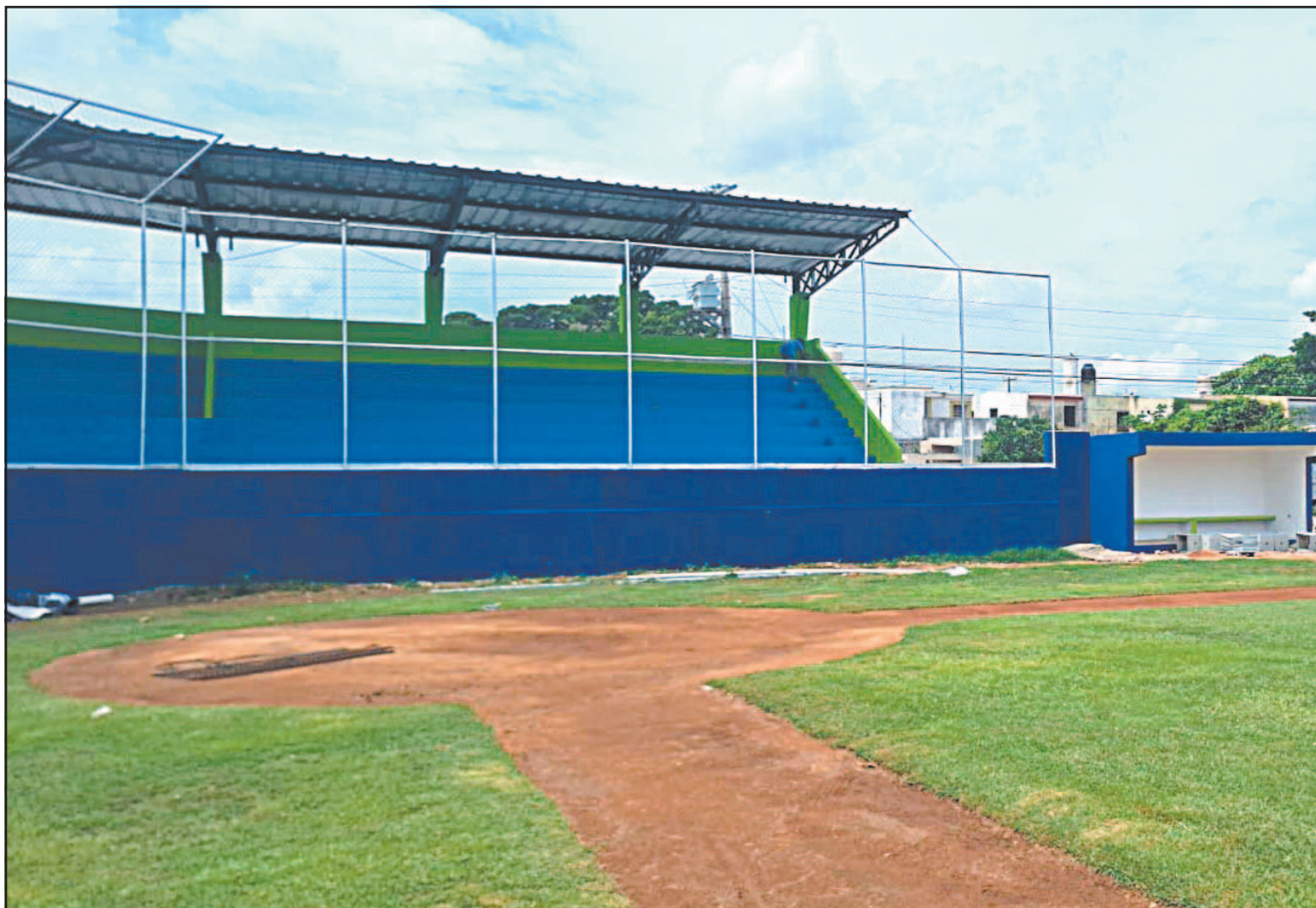
Con 40 años de historia, el campo de la Morelos recibió por primera vez un remozamiento mayor que lo llevará a tener luces. (Marco Sánchez)
