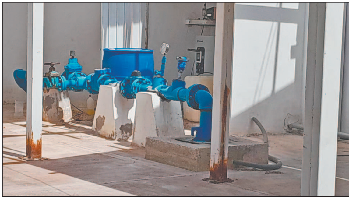
La inestabilidad del servicio eléctrico inició alrededor de la 1:30 de la madrugada, generando apagones.
