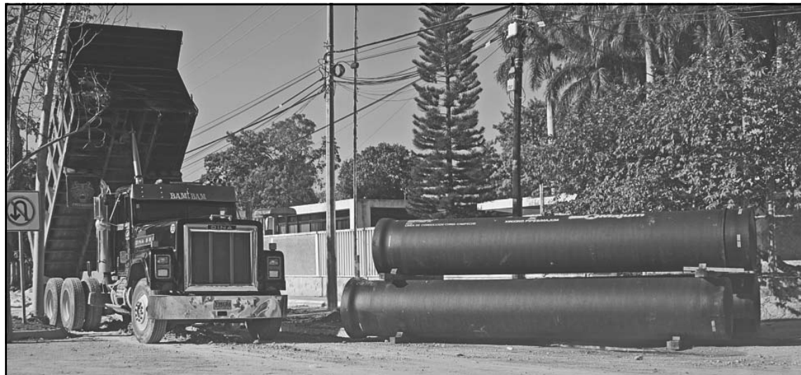
Sustituyen tuberías de 36 y 28 pulgadas a lo largo del trayecto hasta las oficinas del Smapac. (Lucio B.)
