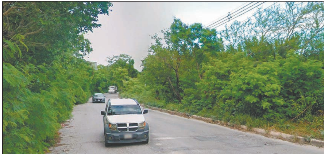
Proyectaron concluir las obras en noviembre próximo; la primera etapa abarcará 15 kilómetros. (O. López)
