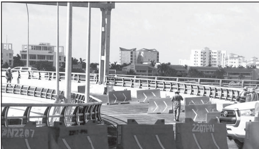
Para mayor seguridad, obreros instalaron cuatro pilotes adicionales y viga metálica.
