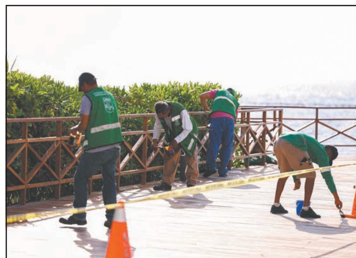
Trabajadores recubrieron los barandales de madera. (POR ESTO!)
