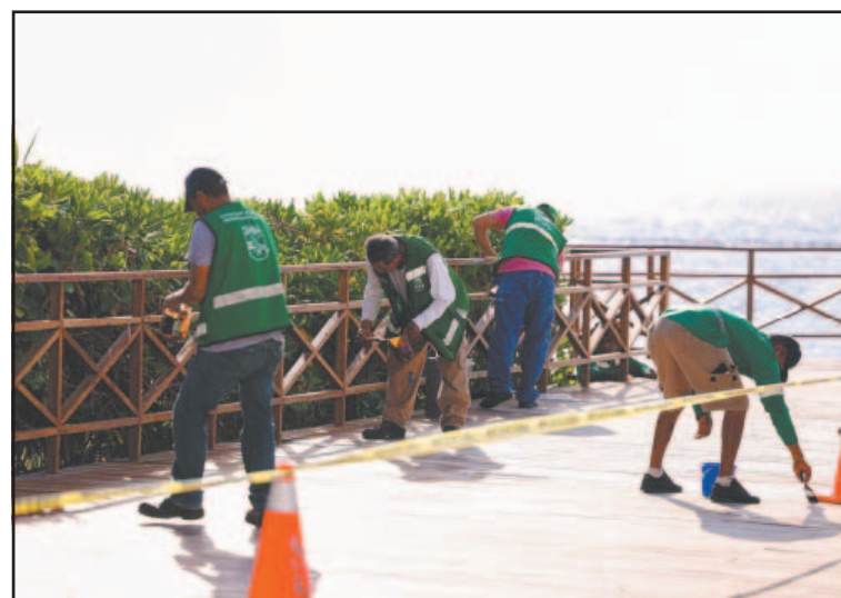
Trabajadores recubrieron los barandales de madera. (POR ESTO!)
