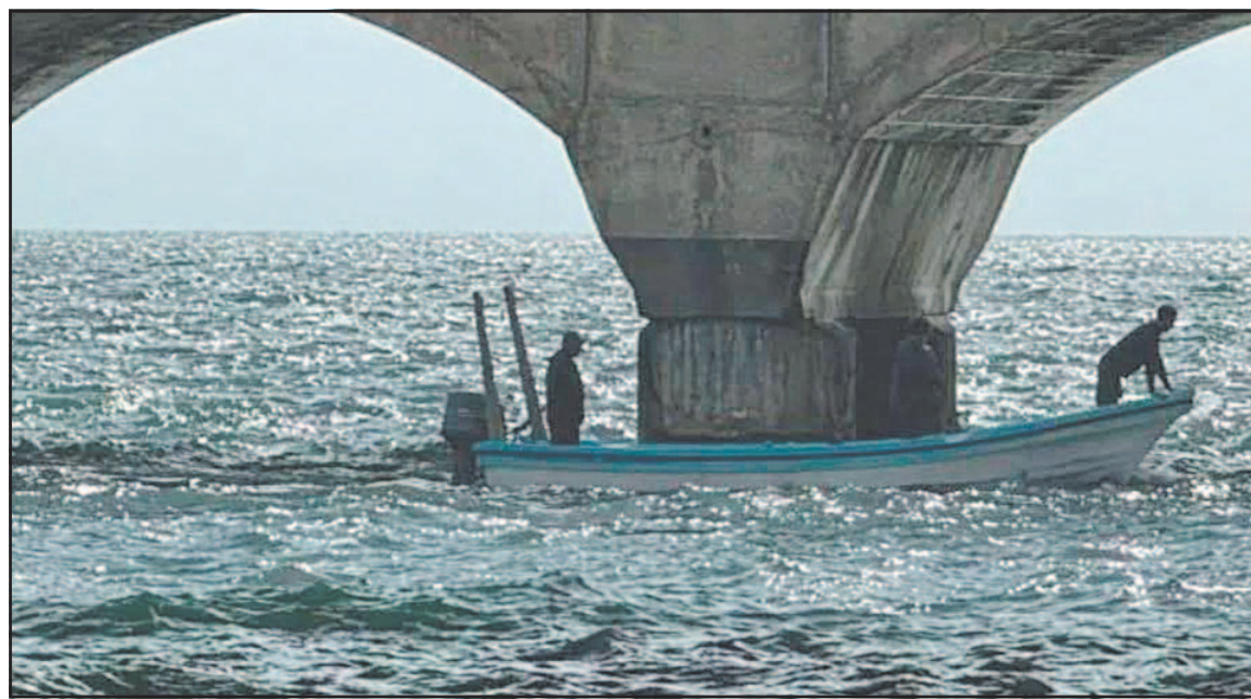
Apyados con lanchas, técnicos instalaron dispositivos para evitar que el hidrocarburo se siga desplazando.
