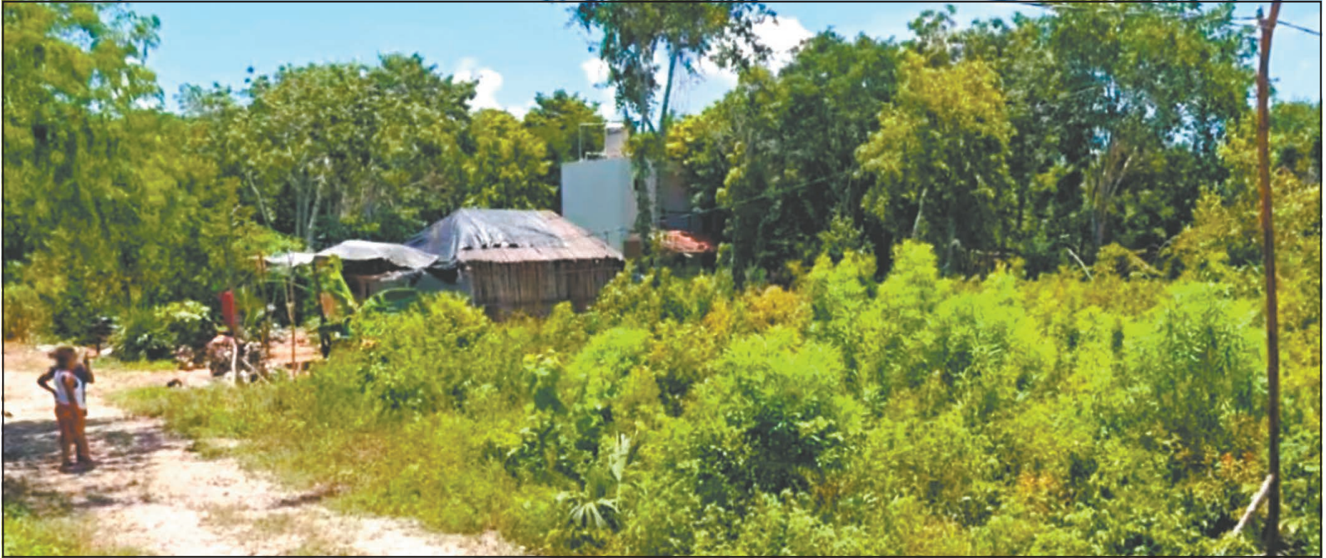
Protección Civil recomendó sustituir viviendas precarias por concreto; de 2 mil hogares, alrededor del 30% tiene láminas de cartón, vulnerables ante un ciclón categoría dos. (O. López)
