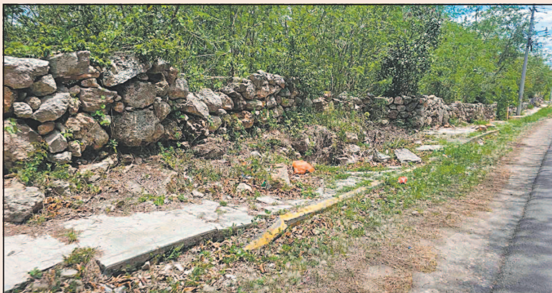
La preocupación consta en el abandono de la zona, donde las señales de tránsito son casi invisibles.
