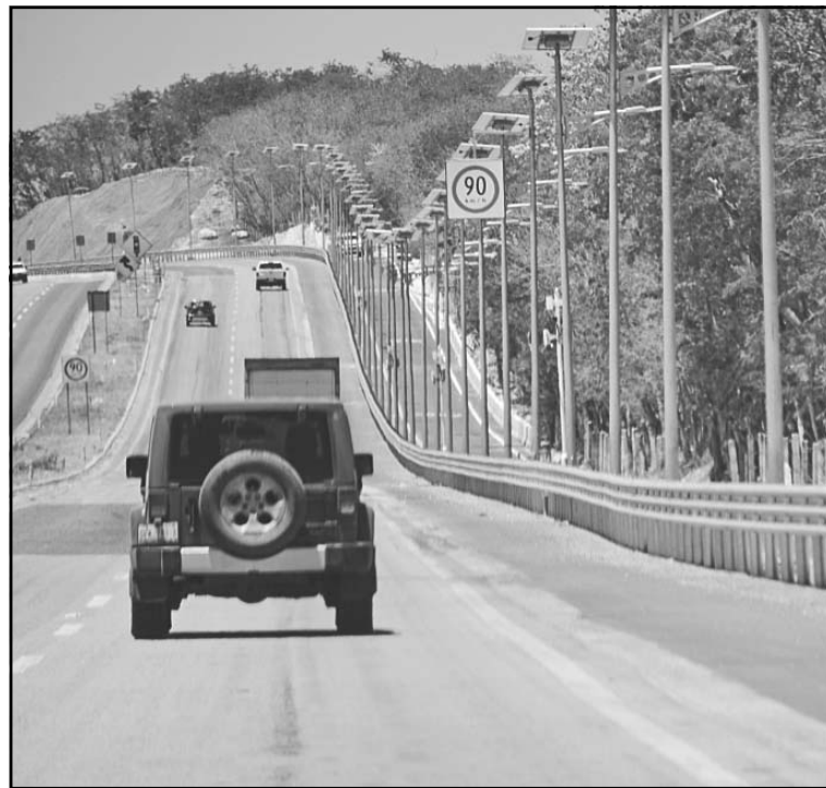
Las obras se enfocarán en repavimentación y mejora del asfalto.
