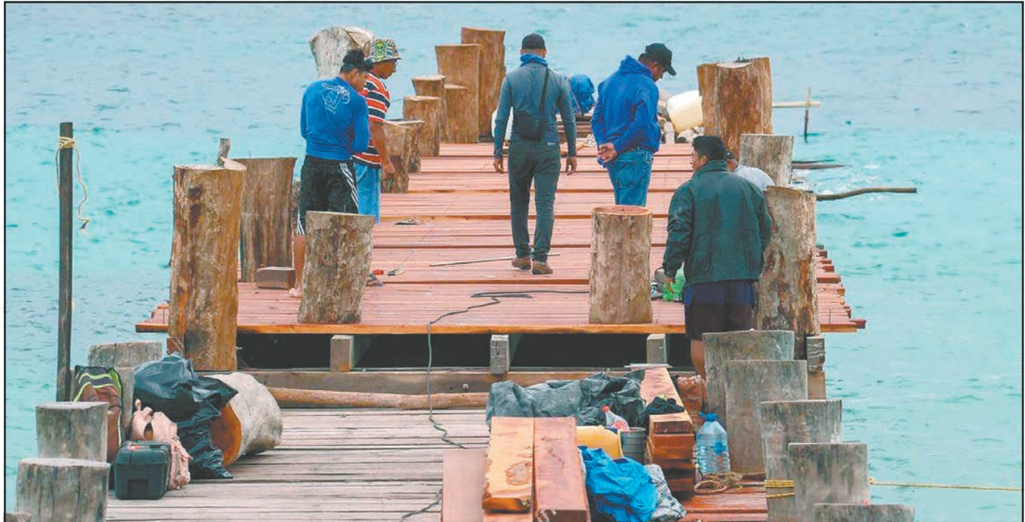
El proyecto contempló sustitución de tramos dañados, incorporación de nuevos elementos y pilotes, a fin de garantizar su durabilidad. (POR ESTO!)
