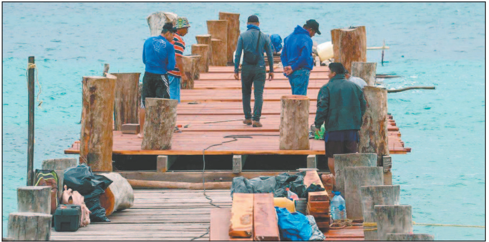
El proyecto contempló sustitución de tramos dañados, incorporación de nuevos elementos y pilotes, a fin de garantizar su durabilidad. (POR ESTO!)
