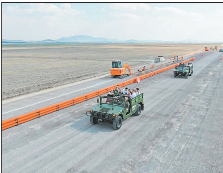
El proyecto tiene una longitud de 58 km con doble vía electrificada.
