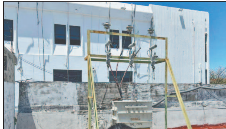
Las instalaciones eléctricas en altura son muy riesgosas. (Perla P.)
