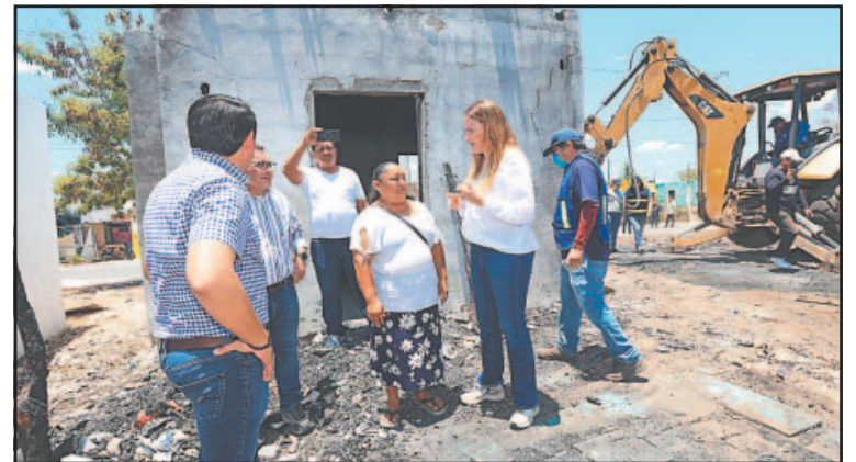
La alcaldesa Cecilia Patrón Laviada verificó el inicio de estas obras.
