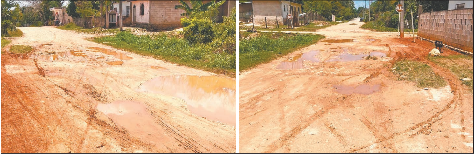
Quejosos afirmaron que las lluvias recientes anegaron diversos sectores de la cabecera, lo que provocó lodazales que al secarse contaminan depósitos de agua. (Fotos E. Cauch)
