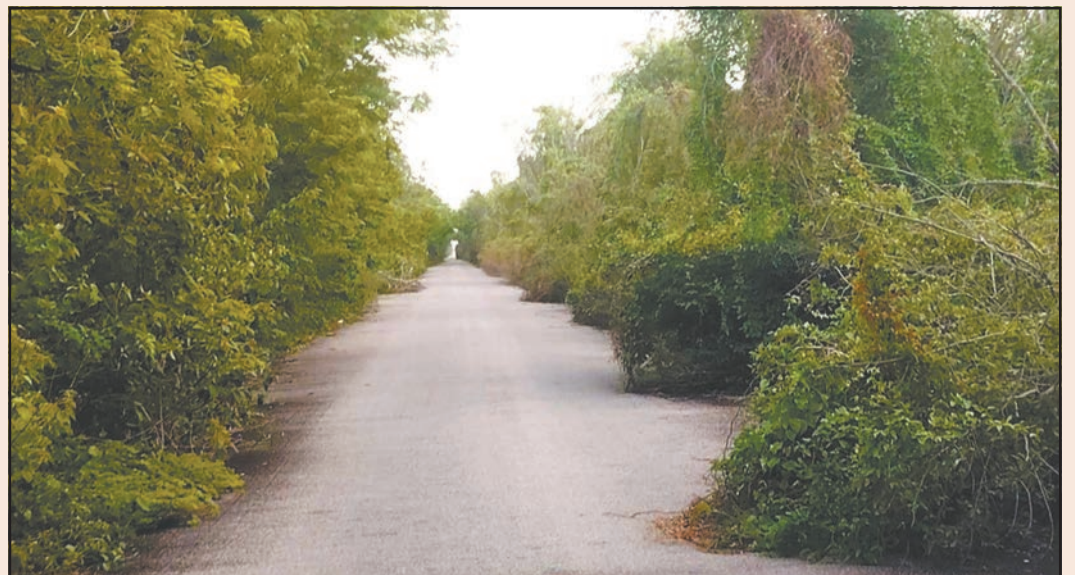
La carretera de Mahahual a Xcalak tiene maleza en las orillas y baches en algunos tramos. (E. Martín)
