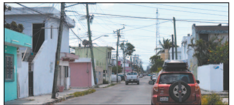
La infraestructura dañada está en la colonia Flores Magón. (A. Blanco)
