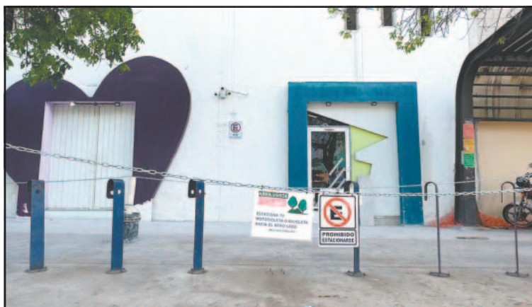
Pidieron restituir área, cerca de la avenida Constituyentes. (G. Escalante)
