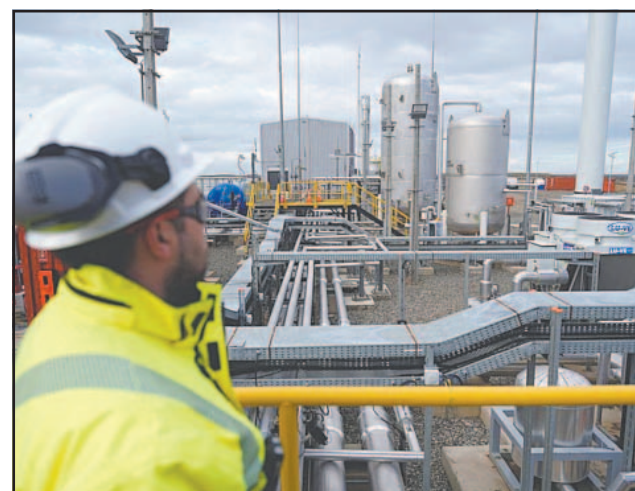
EN las obras de edificación, el proyecto generará alrededor de 6 mil empleos y más de 400 puestos permanentes durante la operación, programada a comienzos del 2030.- (POR ESTO!)
