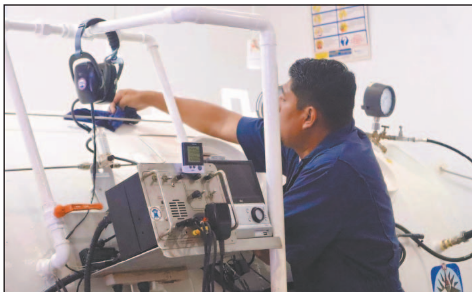
Técnicos revisaron compresores, cilindro y sistema de medición. (Fotos Ovidio López)
