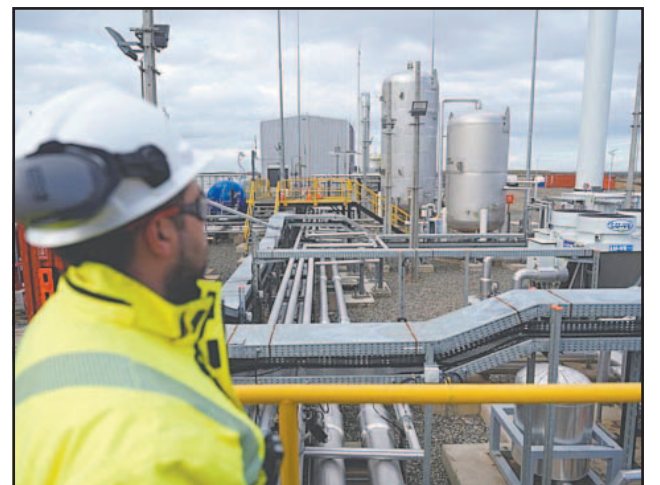
EN las obras de edificación, el proyecto generará alrededor de 6 mil empleos y más de 400 puestos permanentes durante la operación, programada a comienzos del 2030.- (POR ESTO!)
