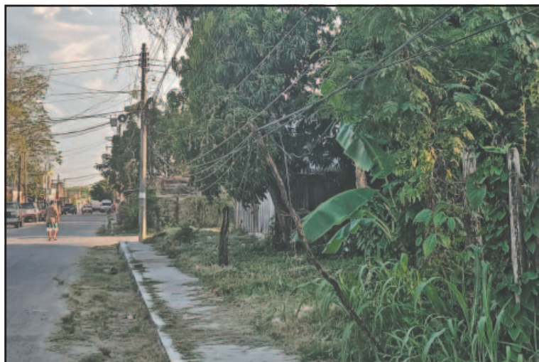
El tendido se encuentra sobre la calle 27 entre 40 y 42. (J.Guevara)
