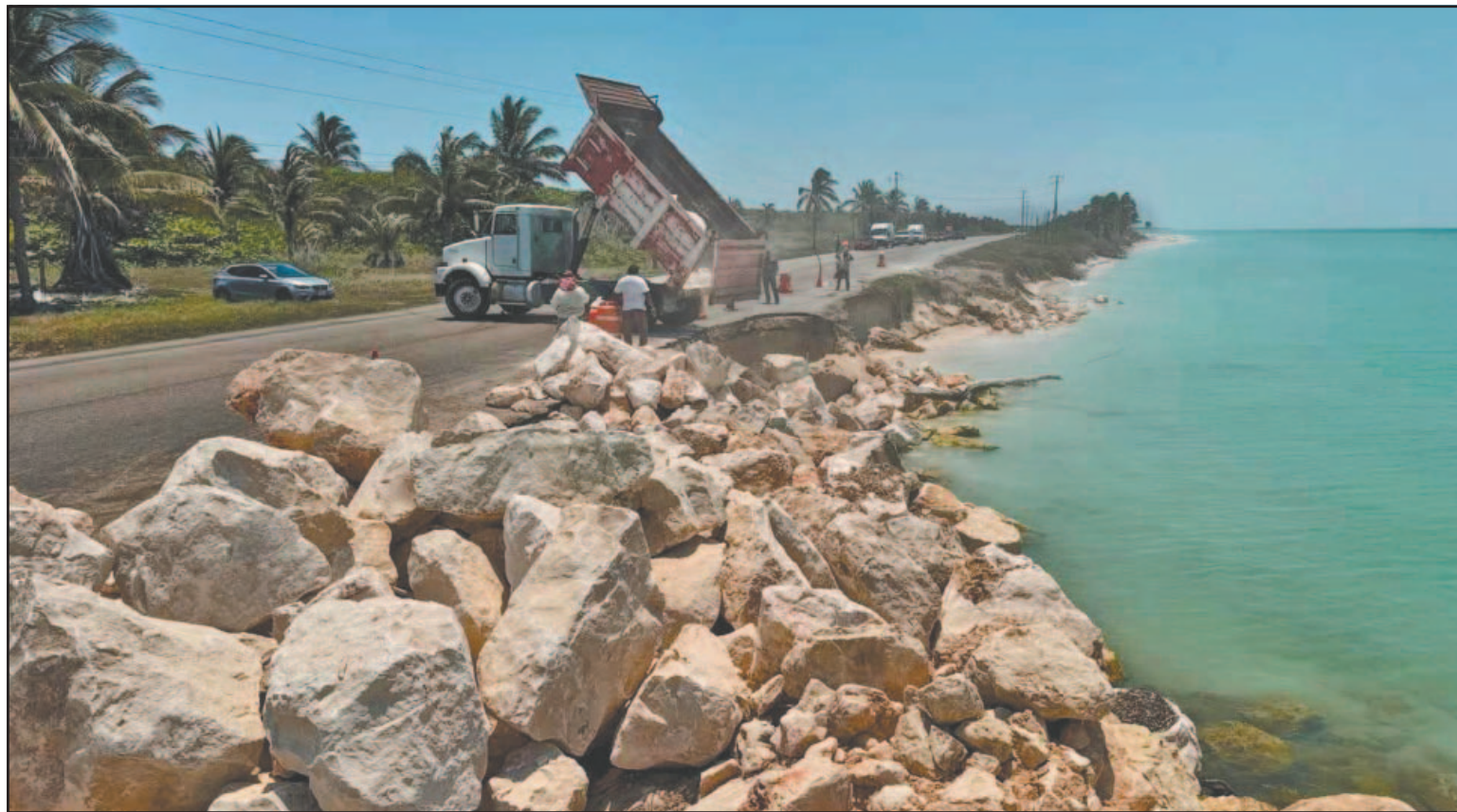
En un hecho que genera esperanza en Sabancuy, trabajadores federales colocaron piedras a modo de escollera sobre el litoral. (P. Díaz)
