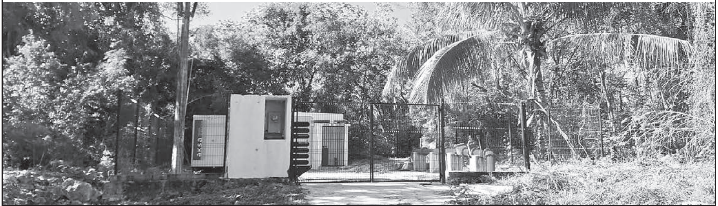
Pipas cisterna abastecieron a los usuarios, luego de parar los equipos de bombeo para evitar daños por apagones. (Fotos Justino Xiu)
