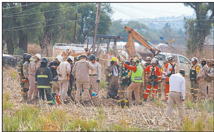
La ordeña de hidrocarburo ilegal fue detectada en Acolman. (Agencias)
