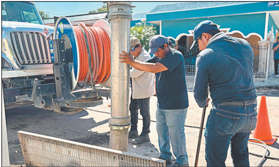
Las intervenciones en el sistema de drenaje aseguran menos encharcamientos en puntos críticos.
