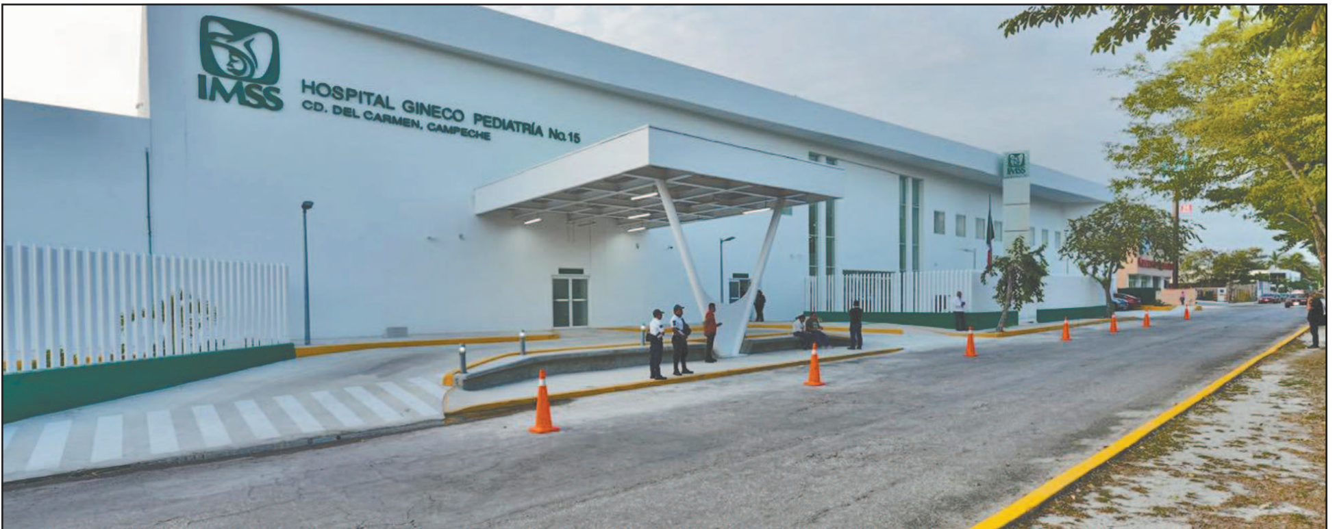
El edificio comenzó a ser construido en 2014, pero fue abandonado muchos años hasta que este 2026 se concretó su rescate y es uno de los hospitales más innovadores.
