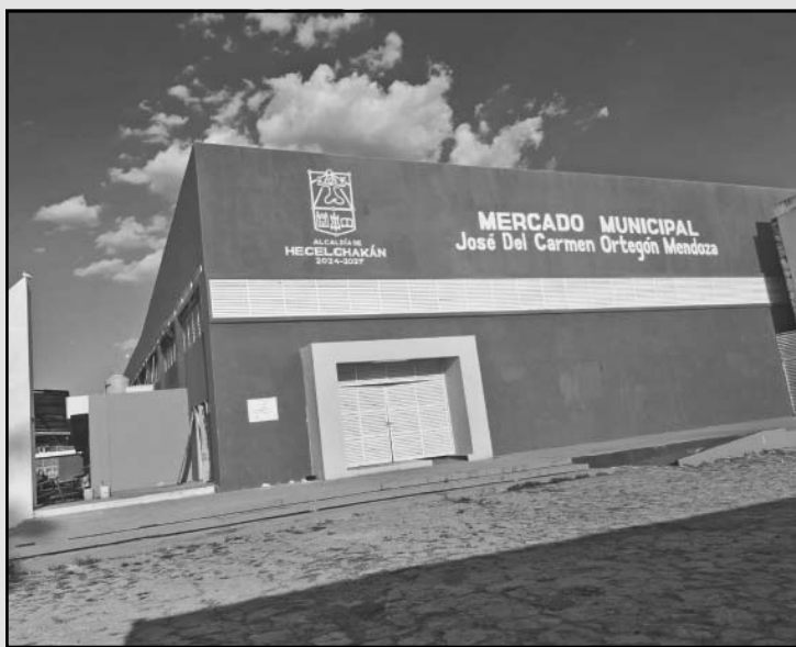
Servicios Públicos no acudió a reparar las tuberías. (A. Caamal)
