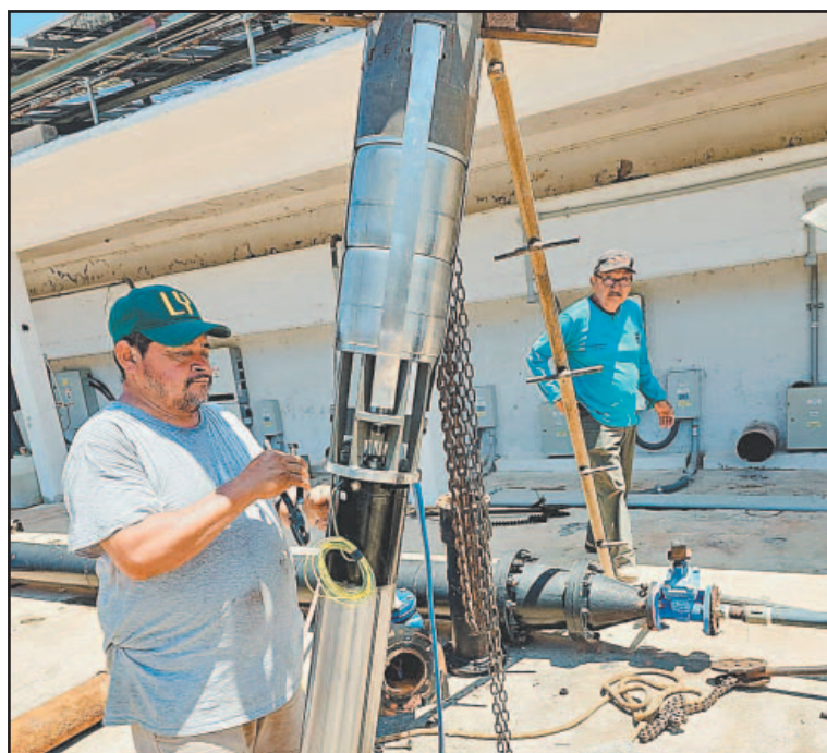
La sustitución del equipo mejorará de manera importante el sistema.
