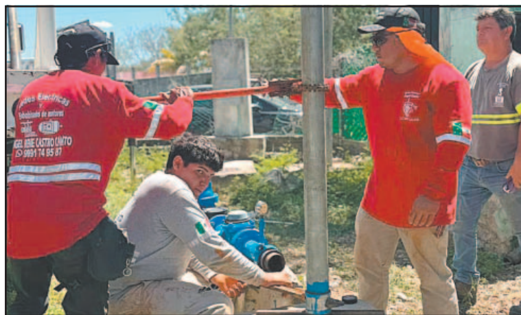
Trabajadores de Kanasín colocan la nueva máquina del sistema.
