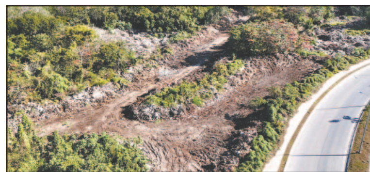
Actualmente sanean el predio que era usado como vertedero. (A. Blanco)
