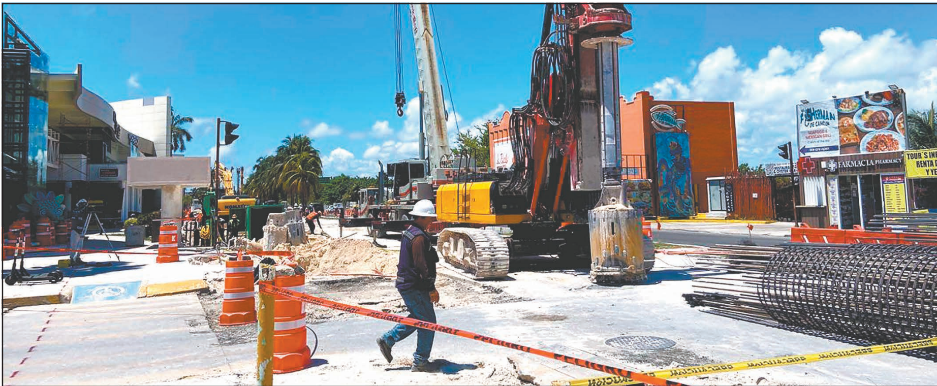
El impacto de la construcción se acentúa en el cruce de las avenidas Luis Donald Colosio, con 16 de abril, donde siguen los trabajos finales; así como el nodo de la Kabah. (POR ESTO!)
