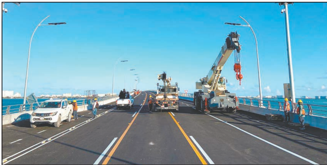
Últiman los detalles de señalética, pruebas de carga y en los acabados en las gazas de subida y bajada.
