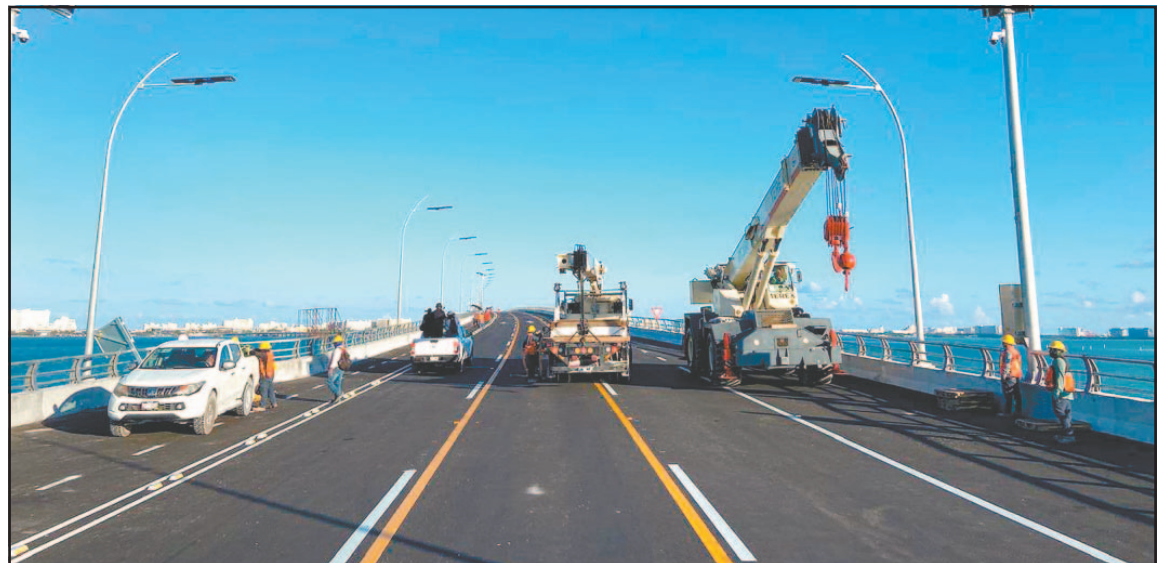
Ultiman los detalles de señalética, pruebas de carga y en los acabados en las gazas de subida y bajada.
