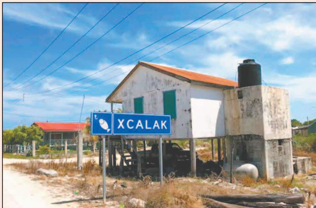
Los quejosos alegaron que el muelle de la comunidad corre gran riesgo de derrumbarse. (F. Olvera)
