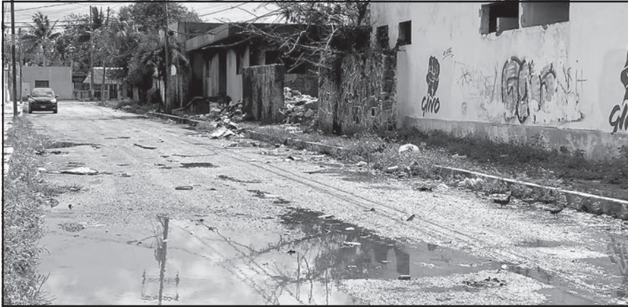
El área se deterioró desde que el nosocomio "Dr. Jesús Kumate Rodríguez" cambió de ubicación.
