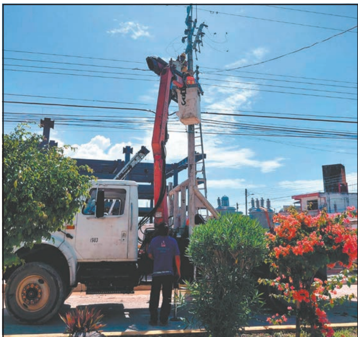
Comisión Federal de Electricidad repuso un transformador. (F. Baeza)
